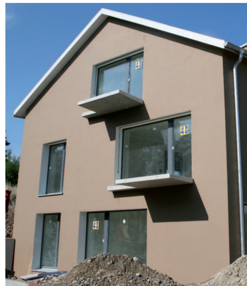
Die Farbe an der Fassade der Alterswohnungen ist der Erde des Hallauer Rebbergs nachempfunden. Bild Wolfgang Schreiber
