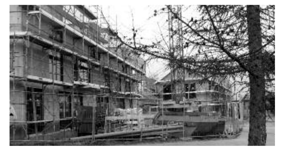
Noch wird fleissig gearbeitet, doch im August werden die Alterswohnungen in Hallau an der Unteren Buckstrasse bezugsfertig sein. Bild Wolfgang Schreiber
